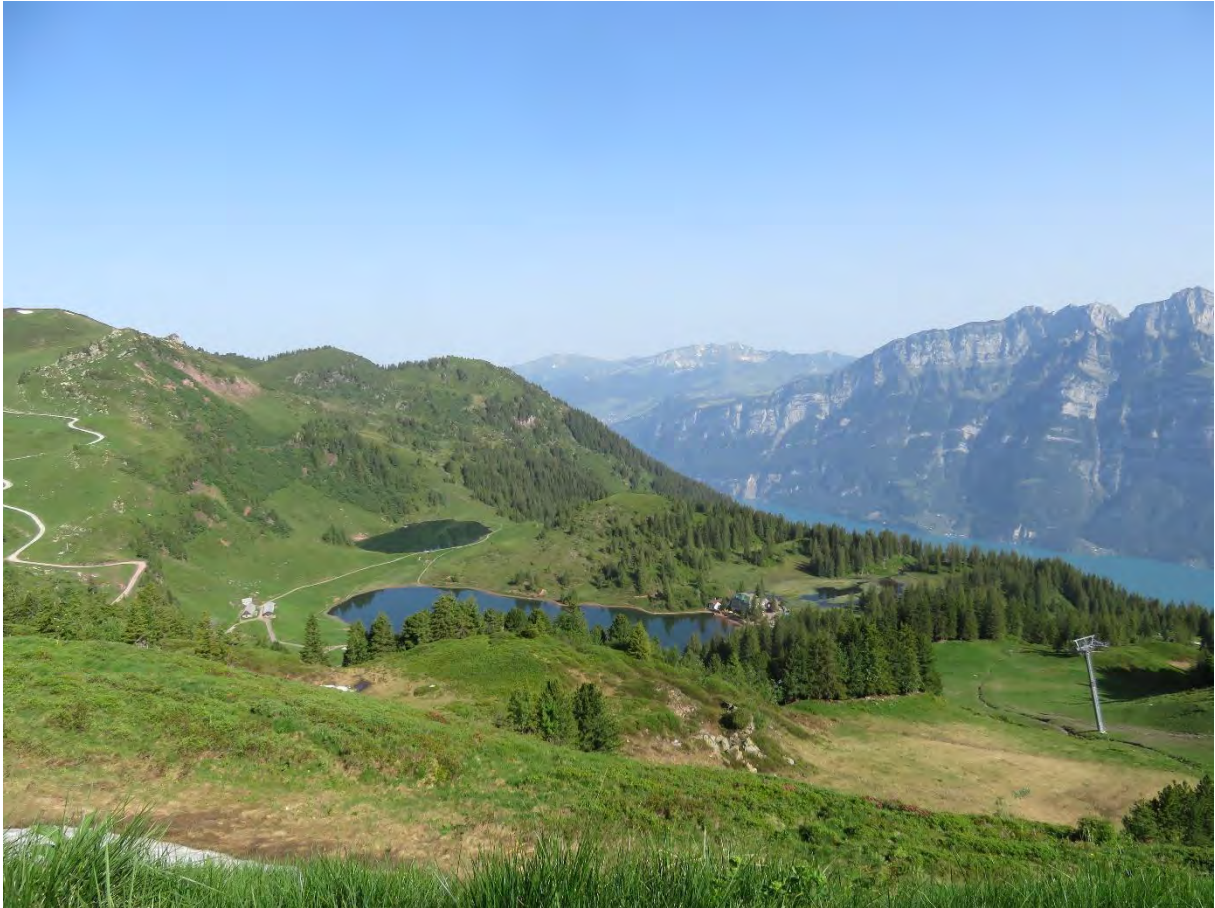
Blick zu den Bergseen auf der Seebenalp, links im Bild das Kiessträsschen für den Materialtransport zur Baustelle auf dem Maschgenkamm
