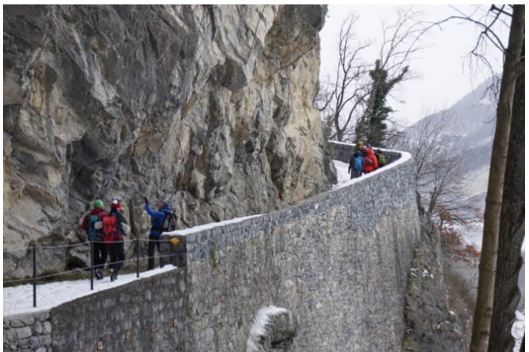
Der restaurierte Strassenabschnitt bei der Hohbergwand.
