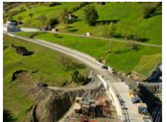
Bau der Verbindungsstrasse nach Valens
