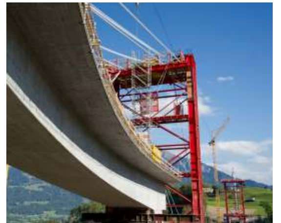
auch der Hilfspylon wächst in die Höhe
