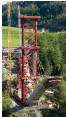
auch der Hilfspylon wächst in die Höhe
