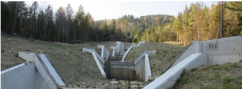
Hochwasserschutz-Verbauungen beim Widenbach
