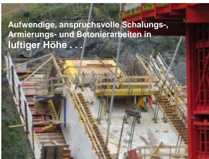
Blick von oben, ca. 35 m über dem Fundament des Pfäferser Widerlagers, hinüber zu jenem auf der Valenser Talseite
