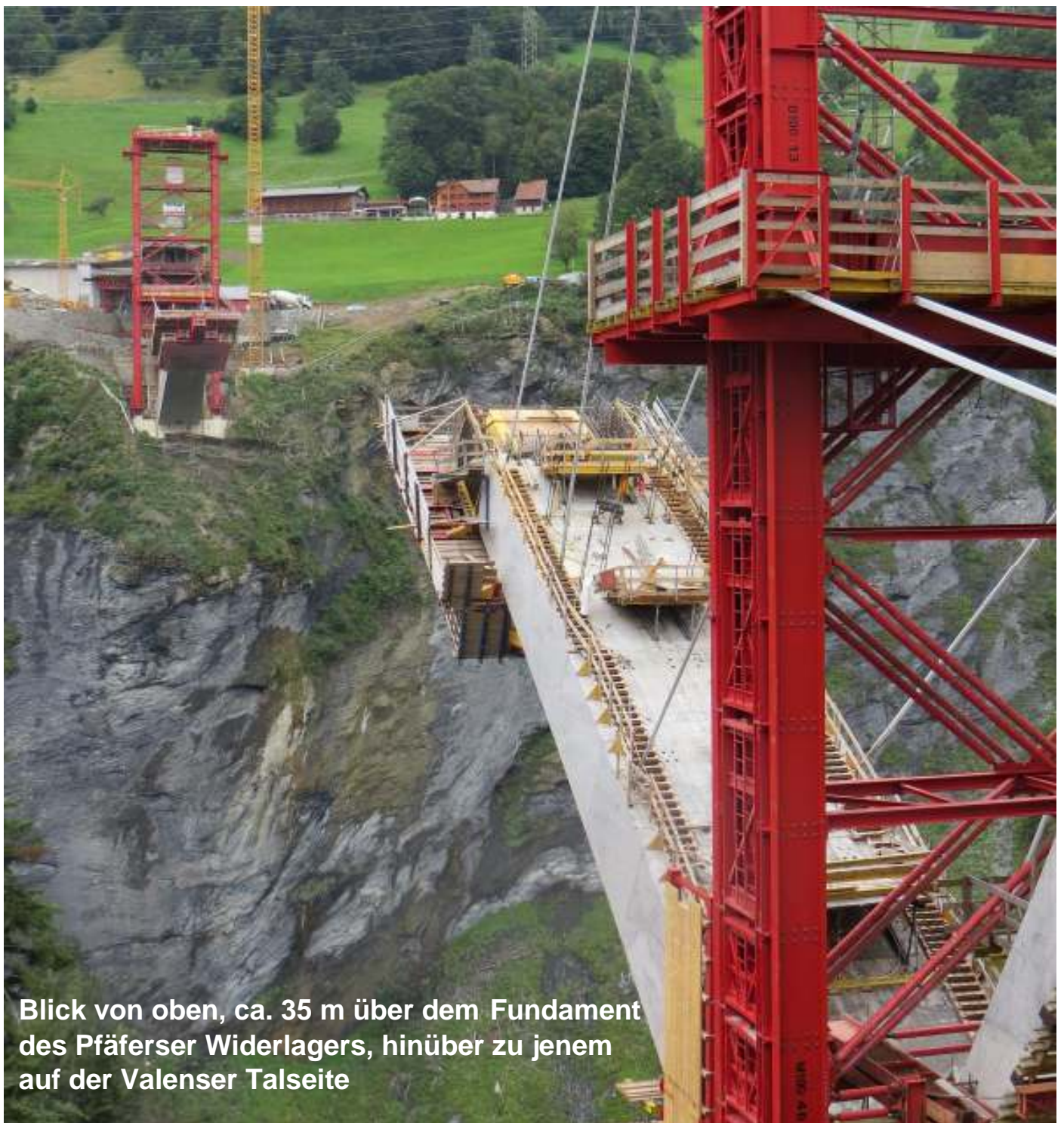
Aufwendige, anspruchsvolle Schalungs-, Armierungs- und Betonierarbeiten in luftiger Höhe ...
