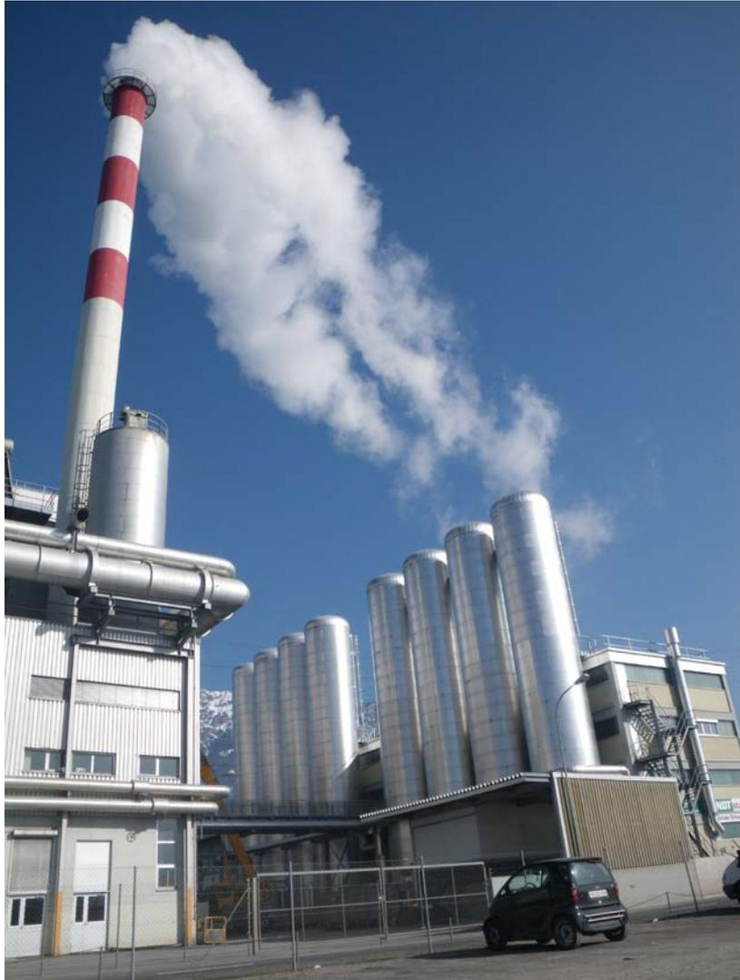
*Der Heisswasserspeicher wird zur Zeit um 4 weitere Tanks vergrössert*
