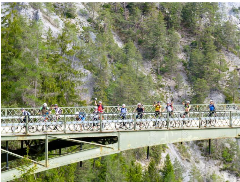
Die alte Brücke über das Versamer Tobel
