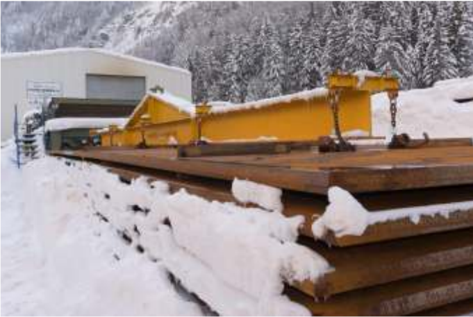
Anlieferung der Stahlplatten aus Würzburg DE
