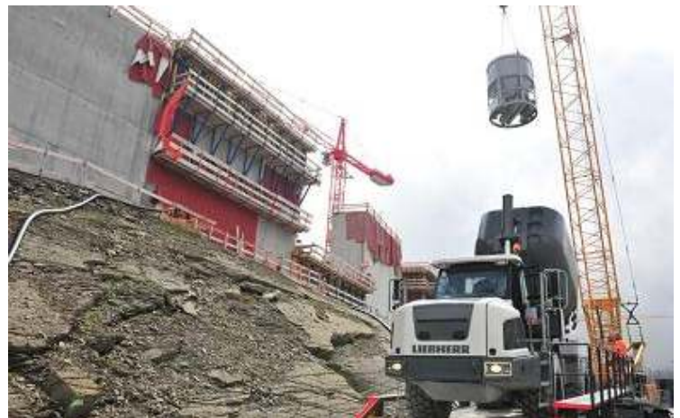
Betonieren auf 2474 m ü. M. am Muttsee ...
