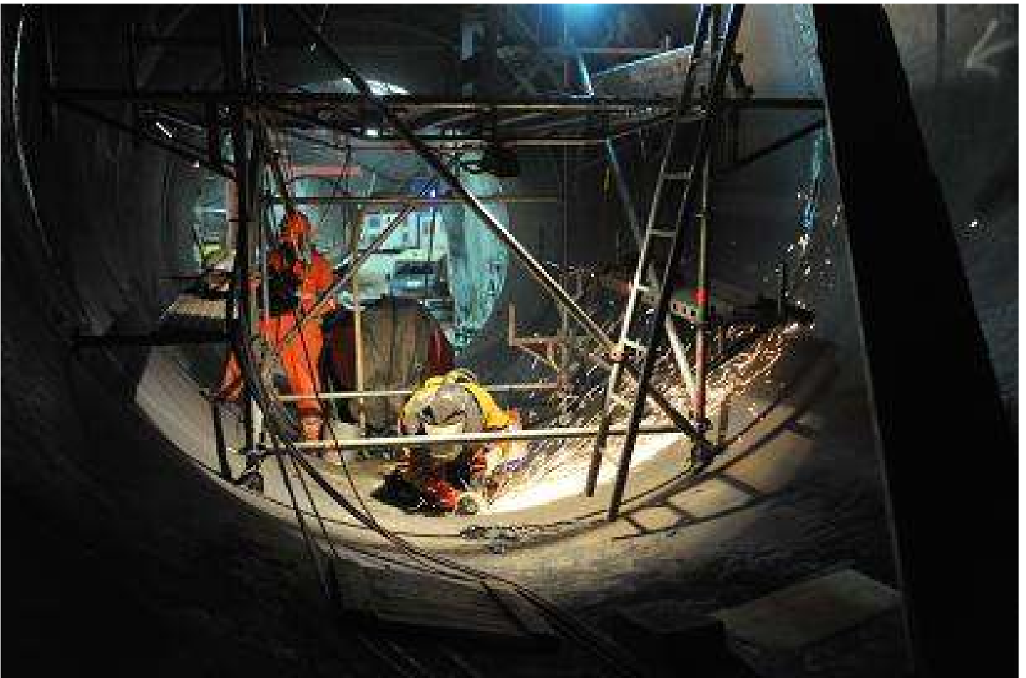
Die anspruchsvollen Schweissarbeiten werden von absoluten Top-Fachleuten ausgeführt
