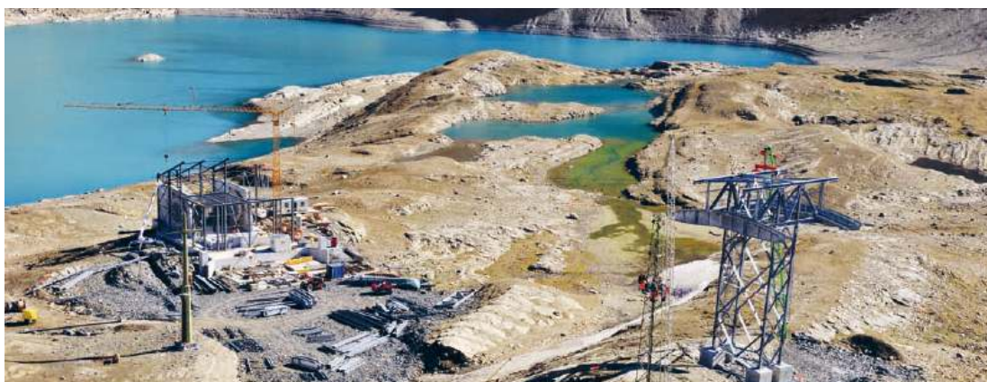
Baubeginn bei der Grossbaustelle - für Erhöhung der Staumauer am (noch) natürlichen Muttsee (im Vordergrund die entstehende Bauseilbahn-Konstruktionen)
